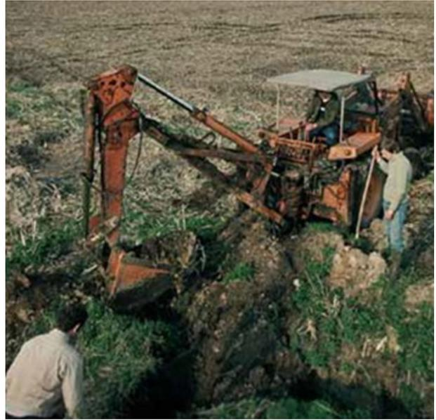
**Abbildung 83:** Ausbaggern der etwa 1,3 m tiefen und alle 4-6 m verlegten Drainagerohre (hier 1980)
